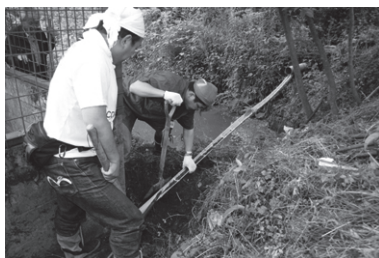
樋の設置作業
